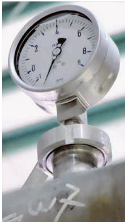
Manometer mit Anschluss unten, Luftblase mitgeplant
